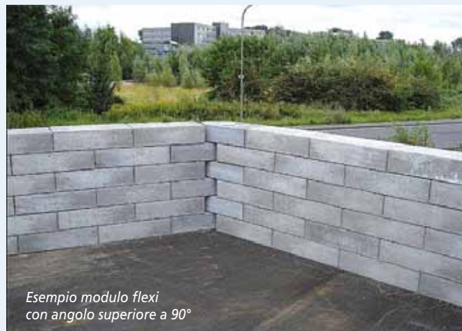
Esempio di parete divisoria per materiali infiammabili
