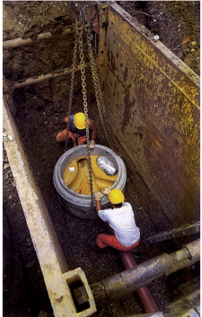
Esempio di posa in opera del fondo con rivestimento in GFK per tubi di ghisa
