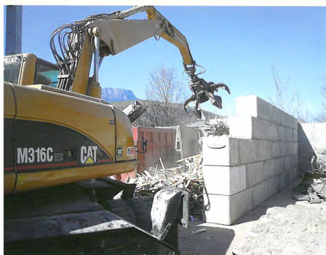
BOLZANO: sito di via Keplero Sostituzione di elementi a T rovescio con nuovo sistema euro serie 600
