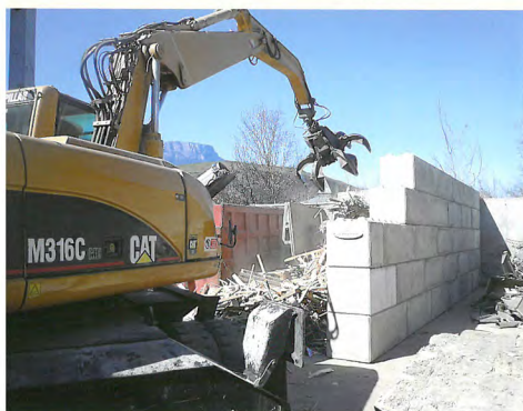
BOLZANO: sito di via Keplero Sostituzione di elementi a T rovescio con nuovo sistema euro-lego serie 600
