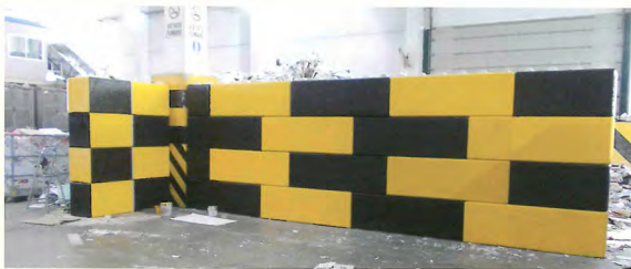
TRENTO: Box per divisione materiale con euro-lego serie 600 presso la ditta Moser Marino
