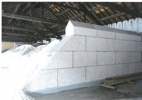
BRENNERO: Dolomiti-lego serie 800 usato come silos per lo stoccaggio di sale
