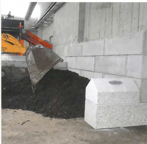
TRENTO: Dolomiti-lego per la formazione di box nel nuovo biodigestore trentino
