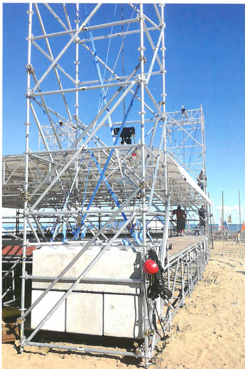
LIGNANO SABBIAADORO: Euro-lego serie 600 ad uso zavorre per palchi spettacoli
